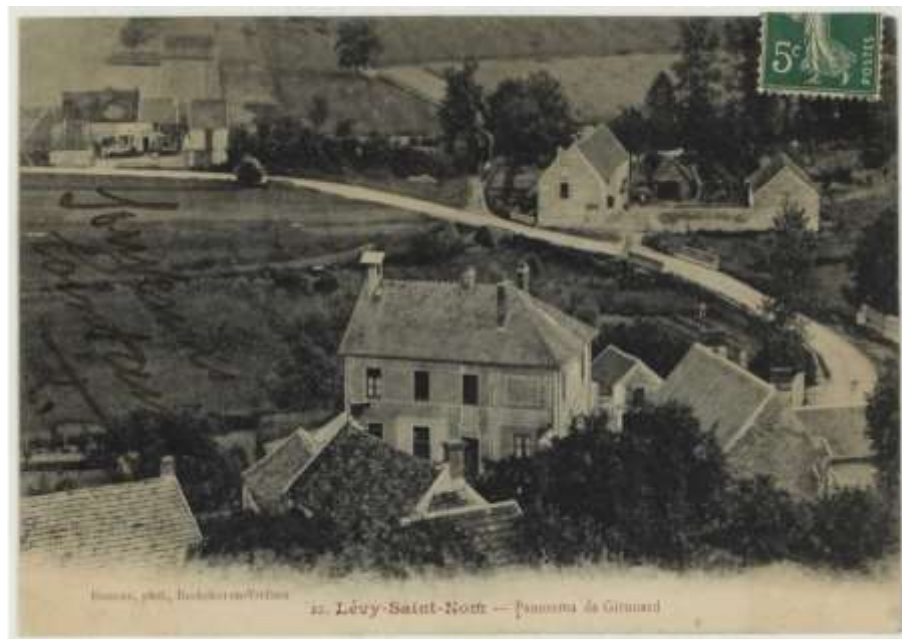
Fig.24 Vue en plongée de la mairie et du dos de la maison Tourtebatte qui fait face à la route de Maincourt bordée par le moulin de la Gire. On voit bien, à sa blancheur, que la chaussée est simplement couverte de pierres concassées.
