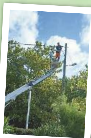
Travaux d'enfouissement des réseaux Route de Maison Blanche.
