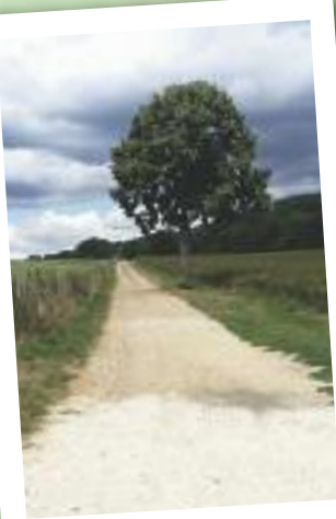
Remise en état du Chemin de Bellepanne
