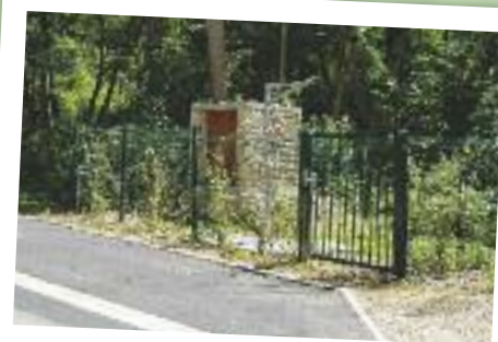
Aménagement du poste de relèvement des eaux usées entre l'Yvette et la station d'épuration avec création d'une place de parking réservée aux véhicules d'intervention
