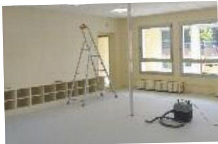
Réfection des peintures et des sols d'une classe de maternelle
