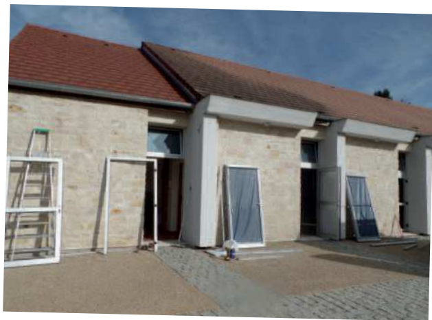
▼ Remplacement portes façade Centre polyvalent
