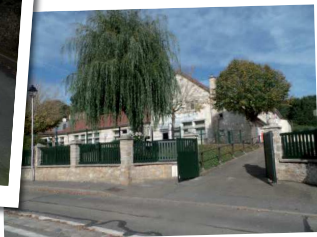
▲ Remplacement portail et barreaudage de l'Ecole des Sources
