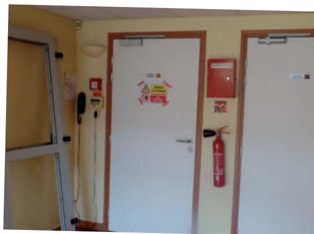
▲ Mise en conformité électricité Centre polyvalent
